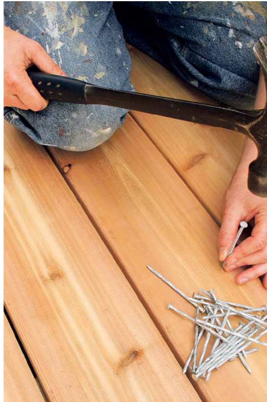
Handarbeit: Der Bau eines Terrassendecks erfordert einiges Geschick – und Ausdauer.
